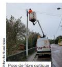
© Agglo de Numéris Pose de fibre optique
