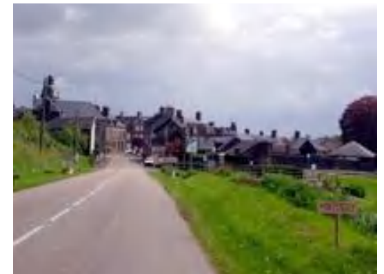
Montbray : implanté sur les pentes du vallon
