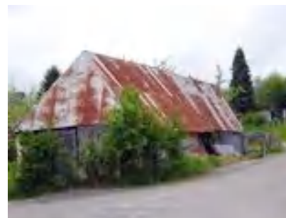
Toiture en tôle à Montbray.
