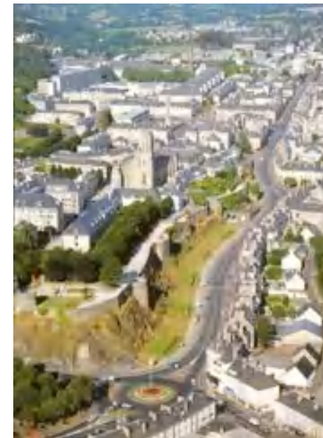
Vue à vol d'oiseau : les remparts et l'urbanisme de la reconstruction.
