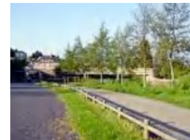
Les berges de la Vire aménagées, au niveau de Pont-Hébert.
