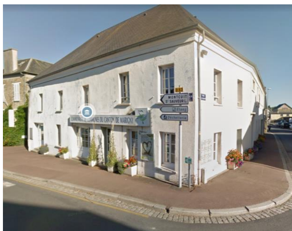
Ancien bâtiment communautaire à l'état actuel
