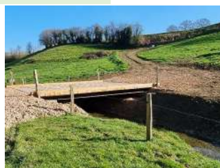
Figure 4 : Remplacement d'une buse – après -
