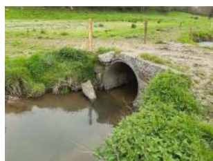
Figure 3 : Remplacement d'une buse – avant -
