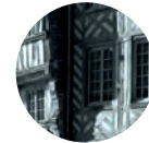
FAÇADE Pans de bois
